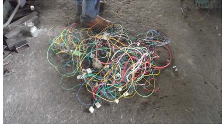
エンジン部分の配線作業中
