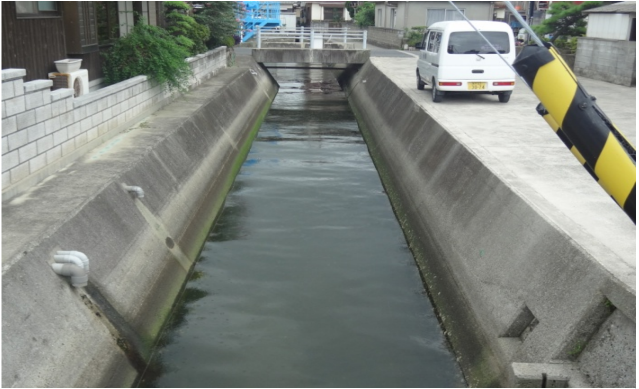
写真 14 改修工事によって川縁はコンクリートで固められた。
