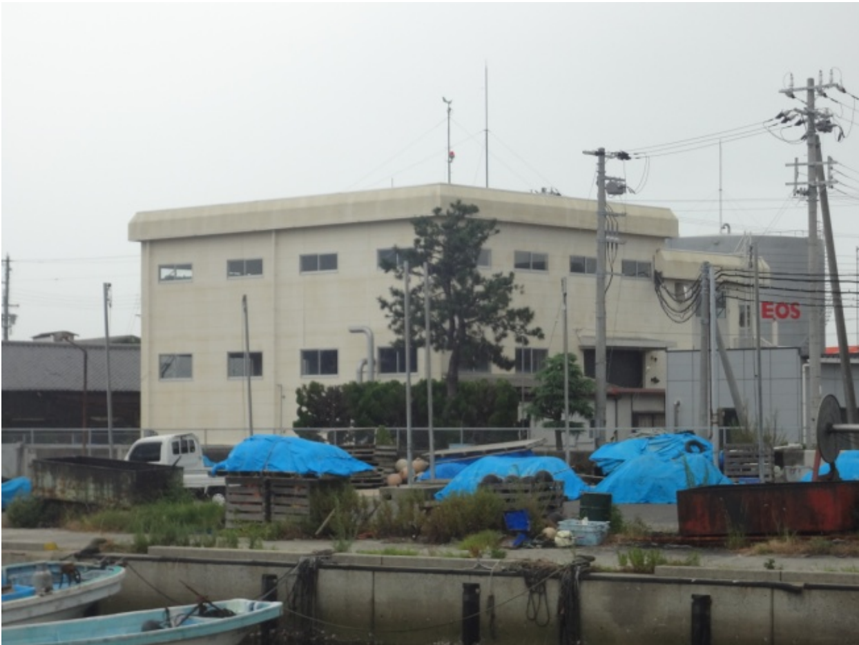
写真 16 兵庫県湊港排水機場
