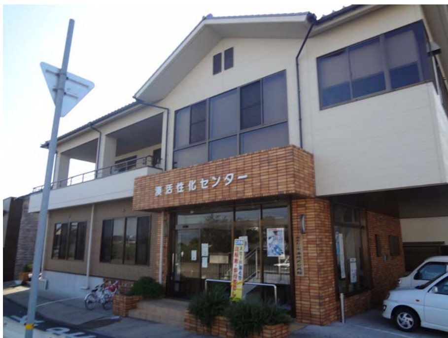
写真 10 湊活性化センター
