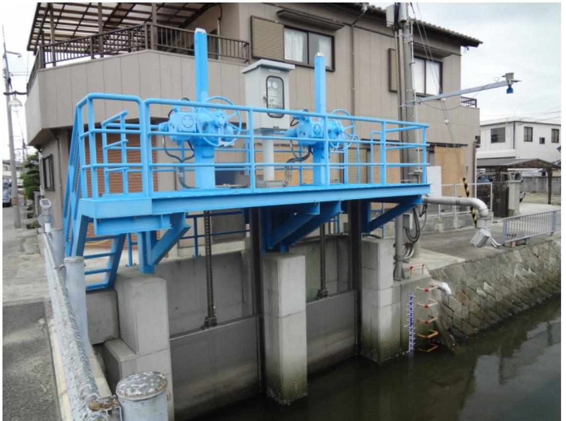
写真 13 普段、水門は閉じられている。
