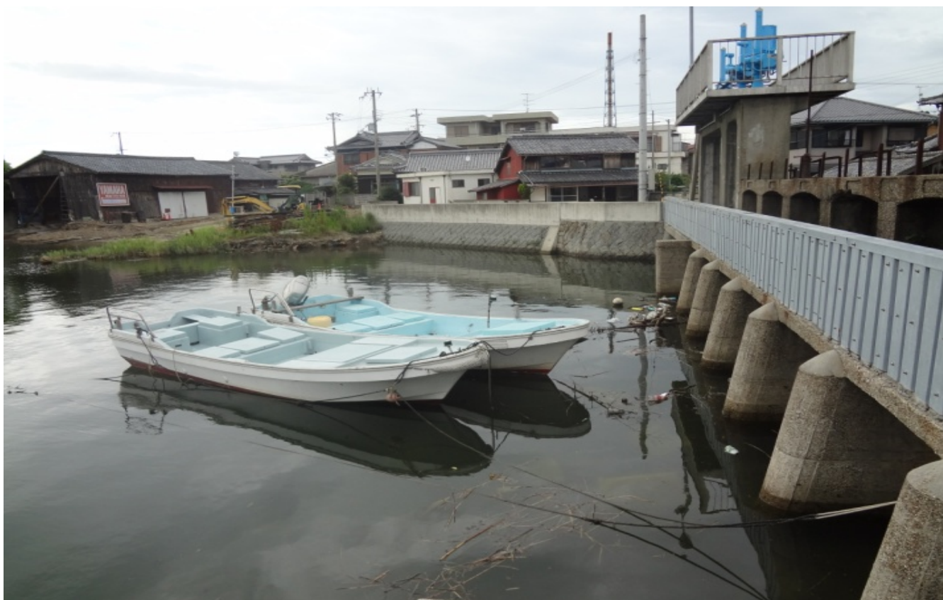
写真 8 三原川の改修工事以前からある古い水門
