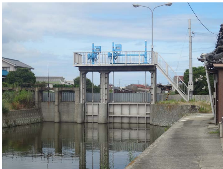
写真 9 古い水門を背面から
