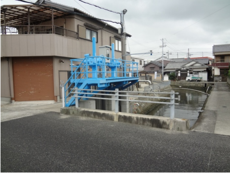
写真 12 湊地区の住宅地の中にも新しい水門が見える
